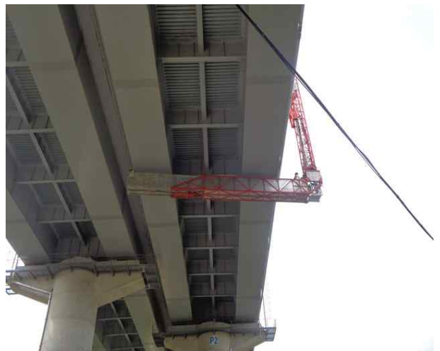
교량점검차를 이용한 근접조사
