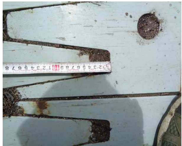
신축이음 유간 측정
